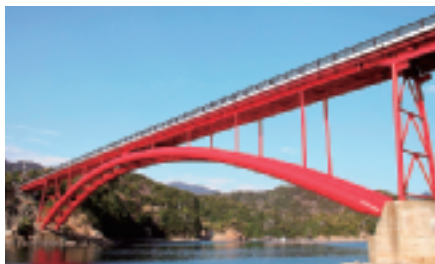
海峡を結ぶ親子大橋は、南島大橋155m、阿曾浦大橋103m。昭和45年に全開通。
