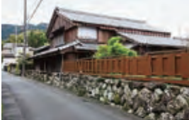
大正から昭和初期にかけてふるさとの朝熊で創作活動が続け、日本の近代彫刻に大きな功績を残した橋本平八の生家が残る。
