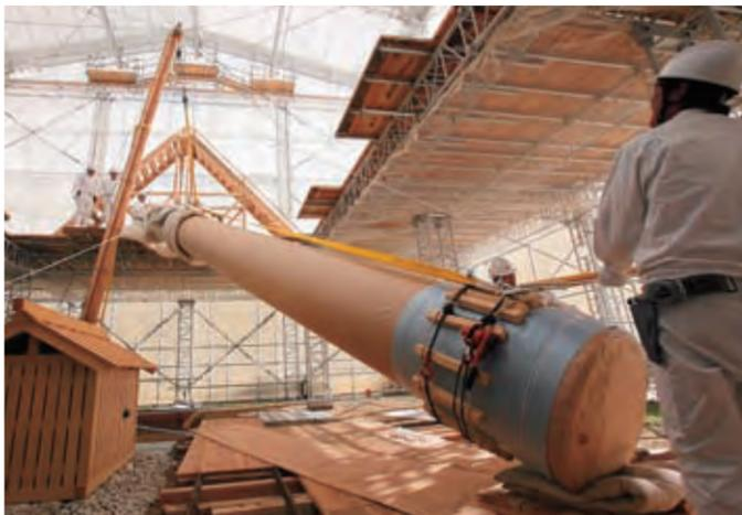
正殿(外宮)の最大の部材は棟持柱(直径約60cm、長さ約10m)だ。造営にあたり、山田工作場から新御敷地へ運び込まれ、すべての柱に先立って建てられた。
